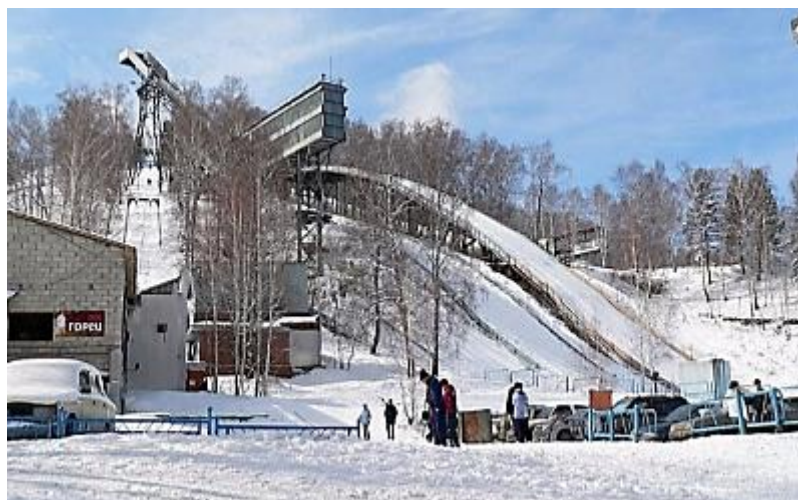
Комплекс сооружений зимних видов спорта «Николаевская сопка»
