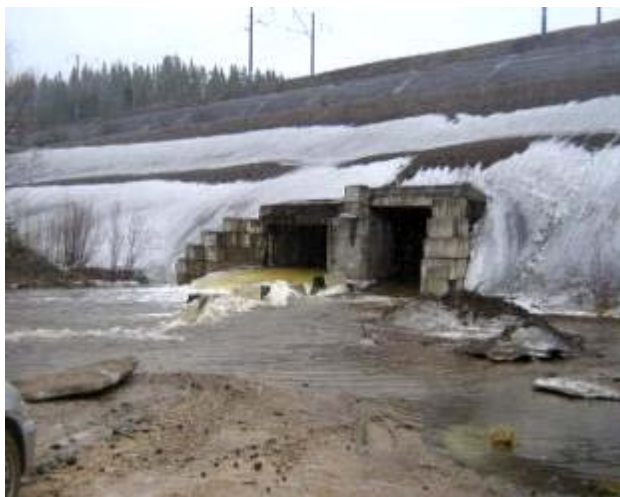
Тоннель под ж.-д. в р-не ост.п. Лесная
